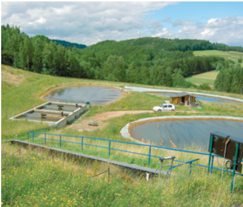
Bioremediationsanlage zur Behandlung schwach radioaktiver Bergbauabwässer. Hinter einem Belüftungsbecken (Vordergrund) und zwei Absetzbecken zur Abscheidung von Feststoffen (links Mitte und links oben) befinden sich mit Characeen bepflanzte Remediationsbecken (oben Mitte und rechts), in denen eine drastische Reduktion v. a. des Arsen- und Schwermetallgehaltes erfolgt (Abb. 1). Foto: Hendrik Schubert
